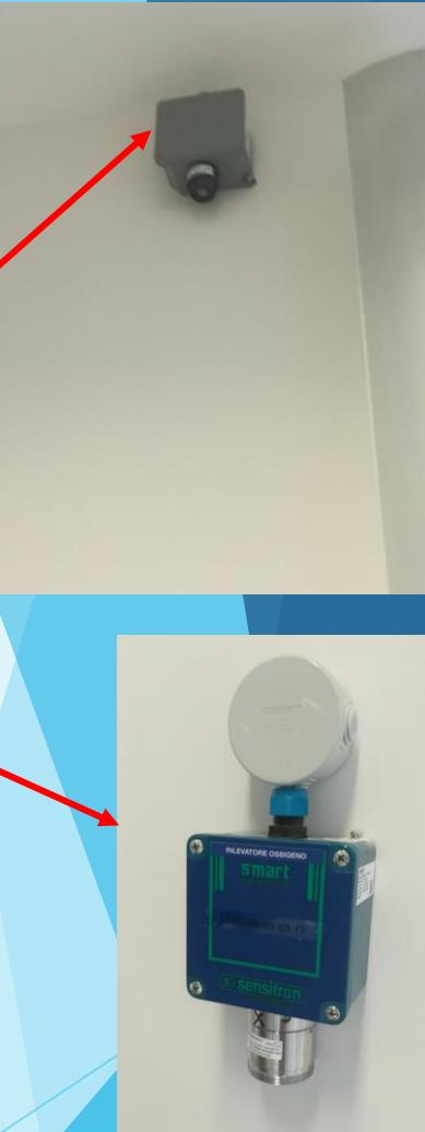
Ogni laboratorio è dotato di rilevatore di fumi, sensore ed allarme gas (se presente metano), sensore da sotto-ossigenazione (se presente linea di un gas compresso)
