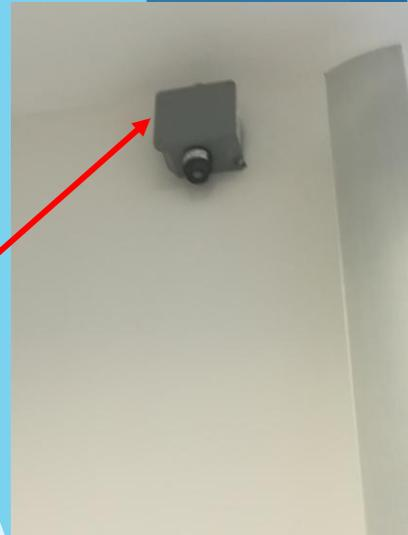
Ogni laboratorio è dotato di rilevatore di fumi, sensore ed allarme gas (se presente metano), sensore da sotto-ossigenazione (se presente linea di un gas compresso)
